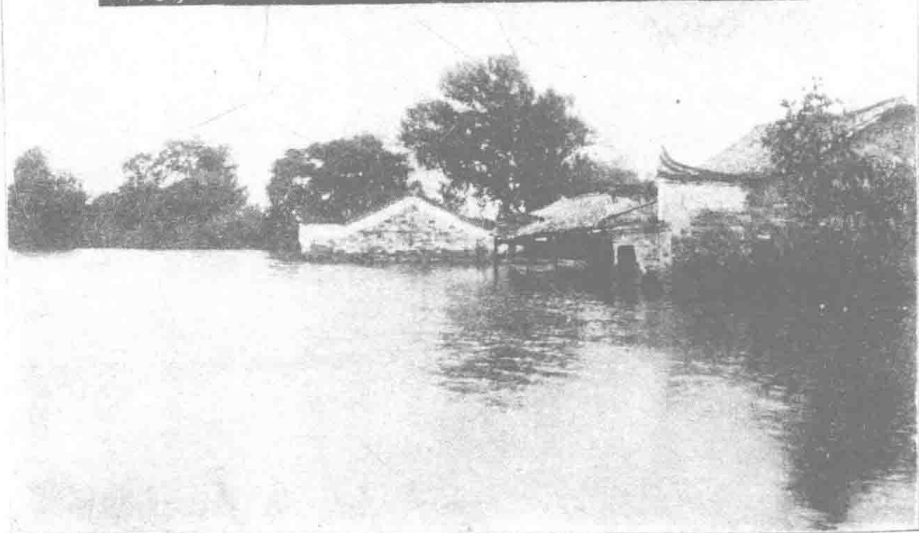
太湖縣第八區史藍保陳嘴北家中及房屋倒之慘狀 太湖縣第八區史藍保陳嘴北家中及房屋倒之慘狀 水災慘狀 水災慘狀
