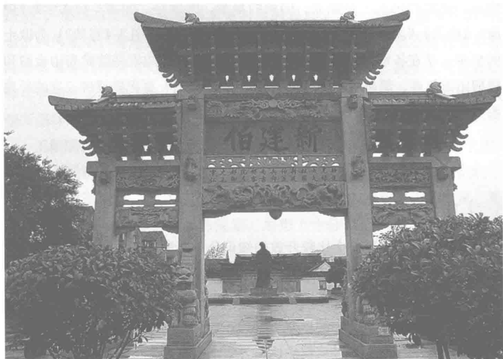
风雨后的彩虹，这是王阳明故居重修的牌楼。
