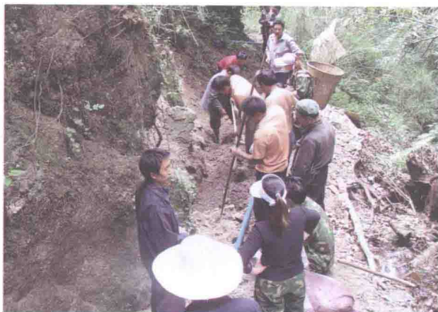
组织抢修村民饮水管道
