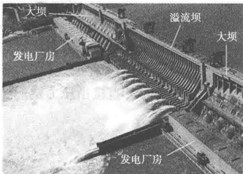
图 1-3-3 坝后式水电厂枢纽布置图
