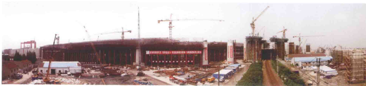
▲ “三角区”连续梁支架及挂篮施工
