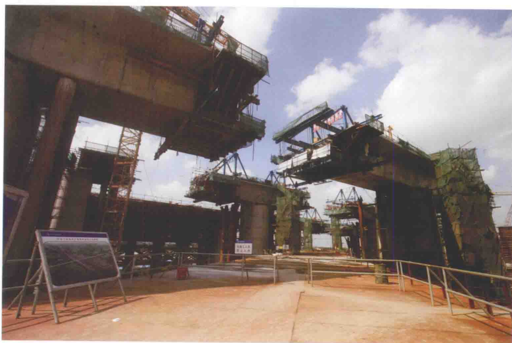
▶ “三角区”连续梁悬浇施工
