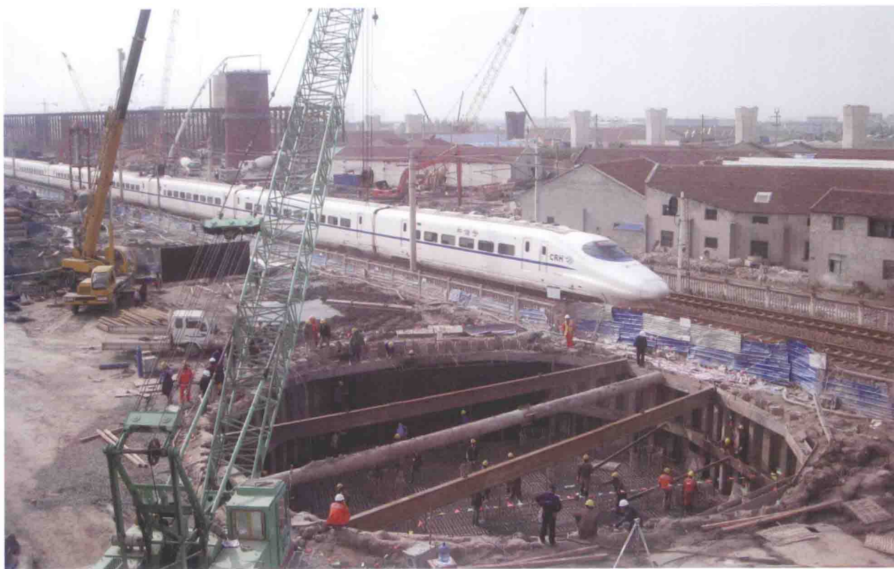
▲ “三角区” 临既有线承台基坑防护
