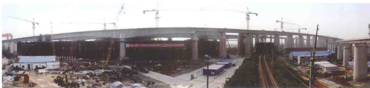
▲ “三角区”施工全景
