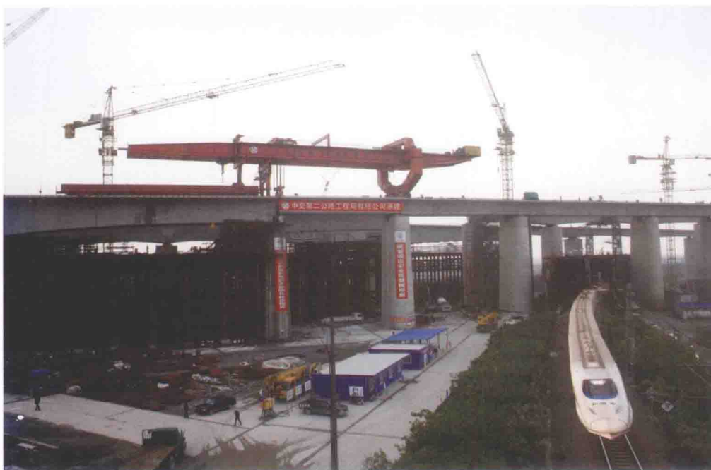
◀ “三角区”施工全景
