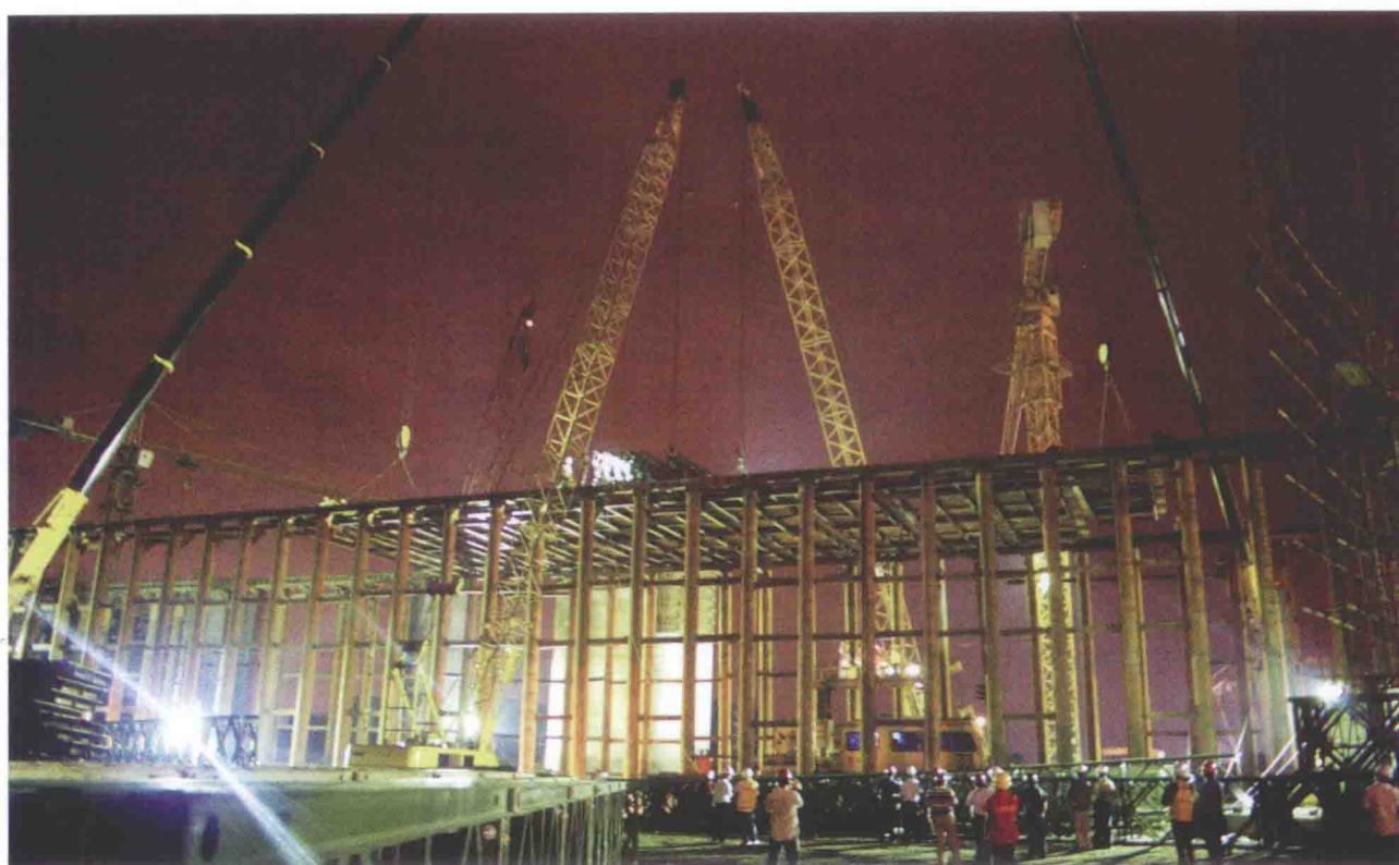
▲ “三角区” 连续梁支架搭设
