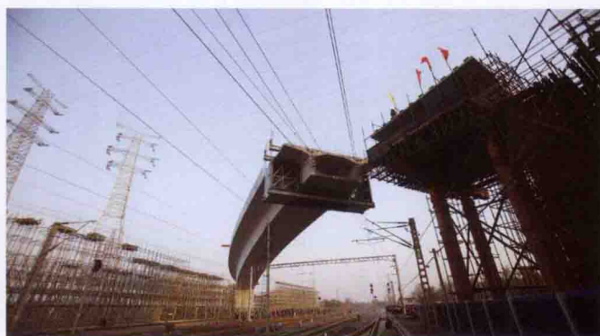
11月1日，14号线跨丰沙铁路转体桥成功合拢
