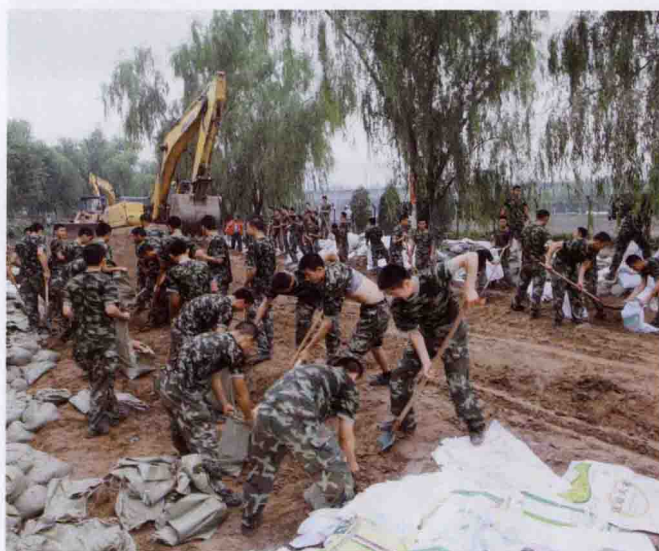
武警北京总队十一支队500余名官兵在京港澳高速南岗洼地段路西抢险筑堤
