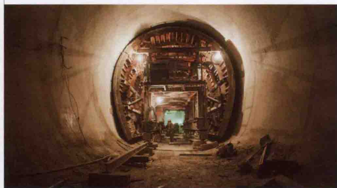
3月30日，6号线一期呼家楼站建设现场
