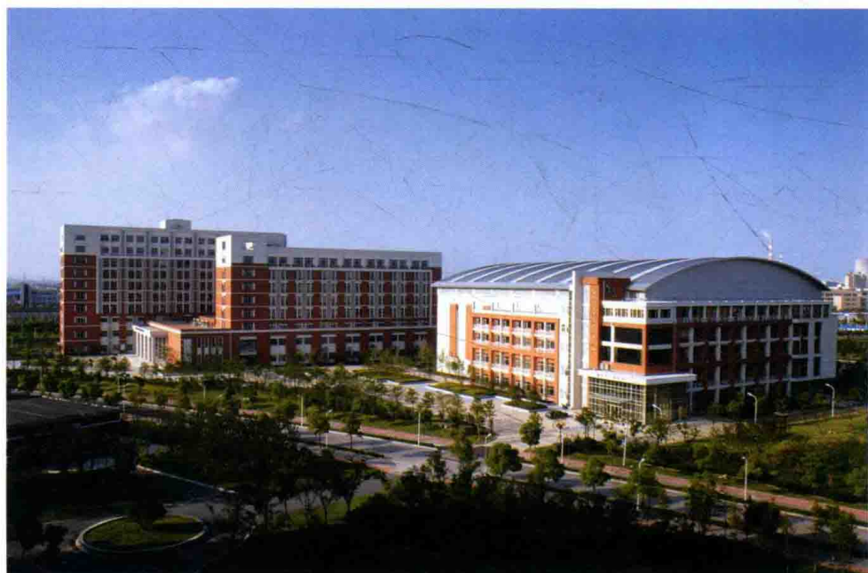
闵行校区的教学科研楼群之一，右为海洋深水实验池国家重点实验室，左为2007年建成的以赵锡成夫人赵朱木兰命名的“木兰船建大楼”。
