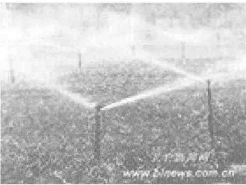
图 1-1 固定管道式喷灌系统在工作
