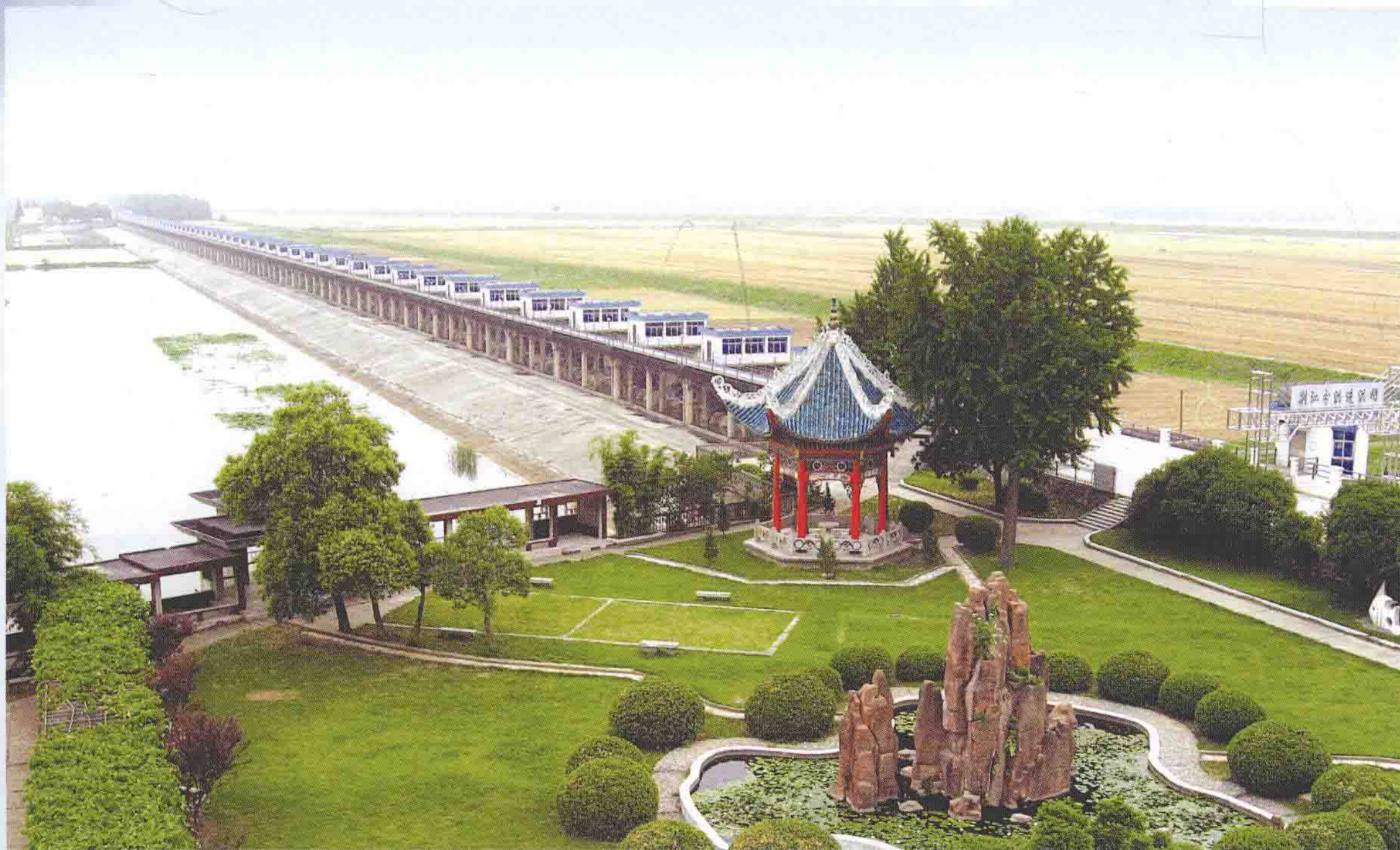
荆江分洪工程进洪闸——北闸
