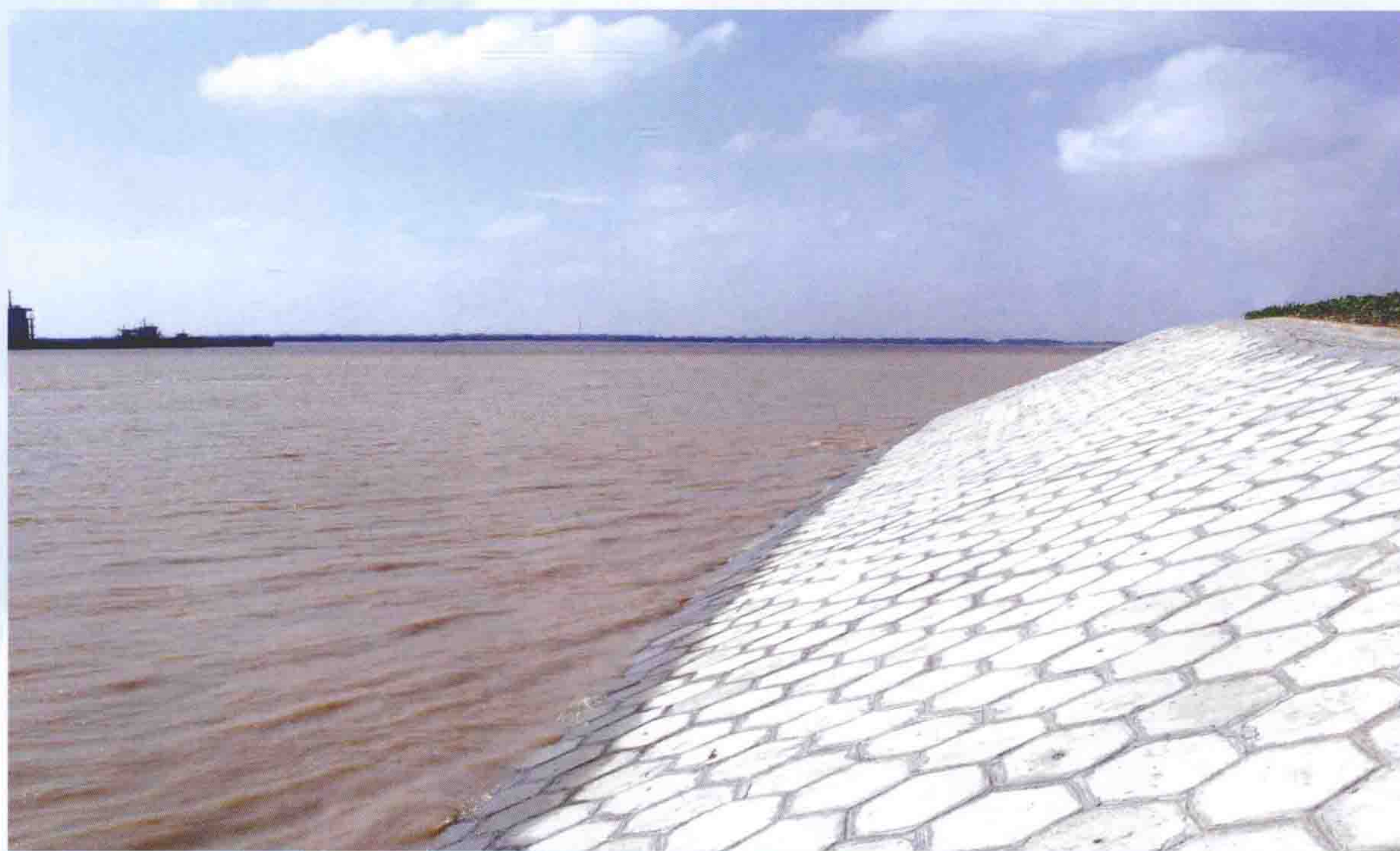
堤防护岸工程
