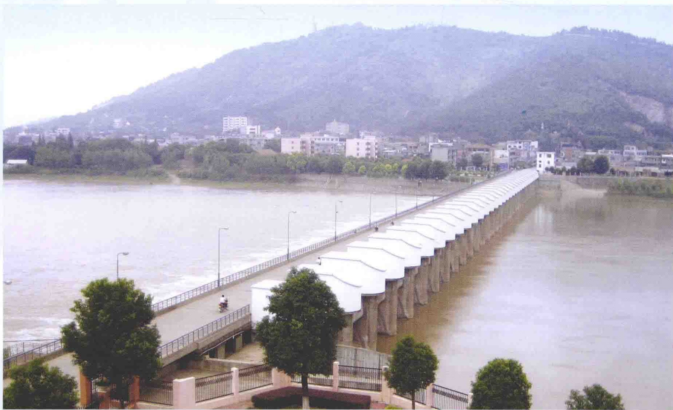
荆江分洪工程节制闸——南闸
