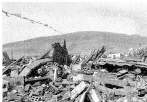
图 1.4 玉树地震后产生的建筑垃圾
