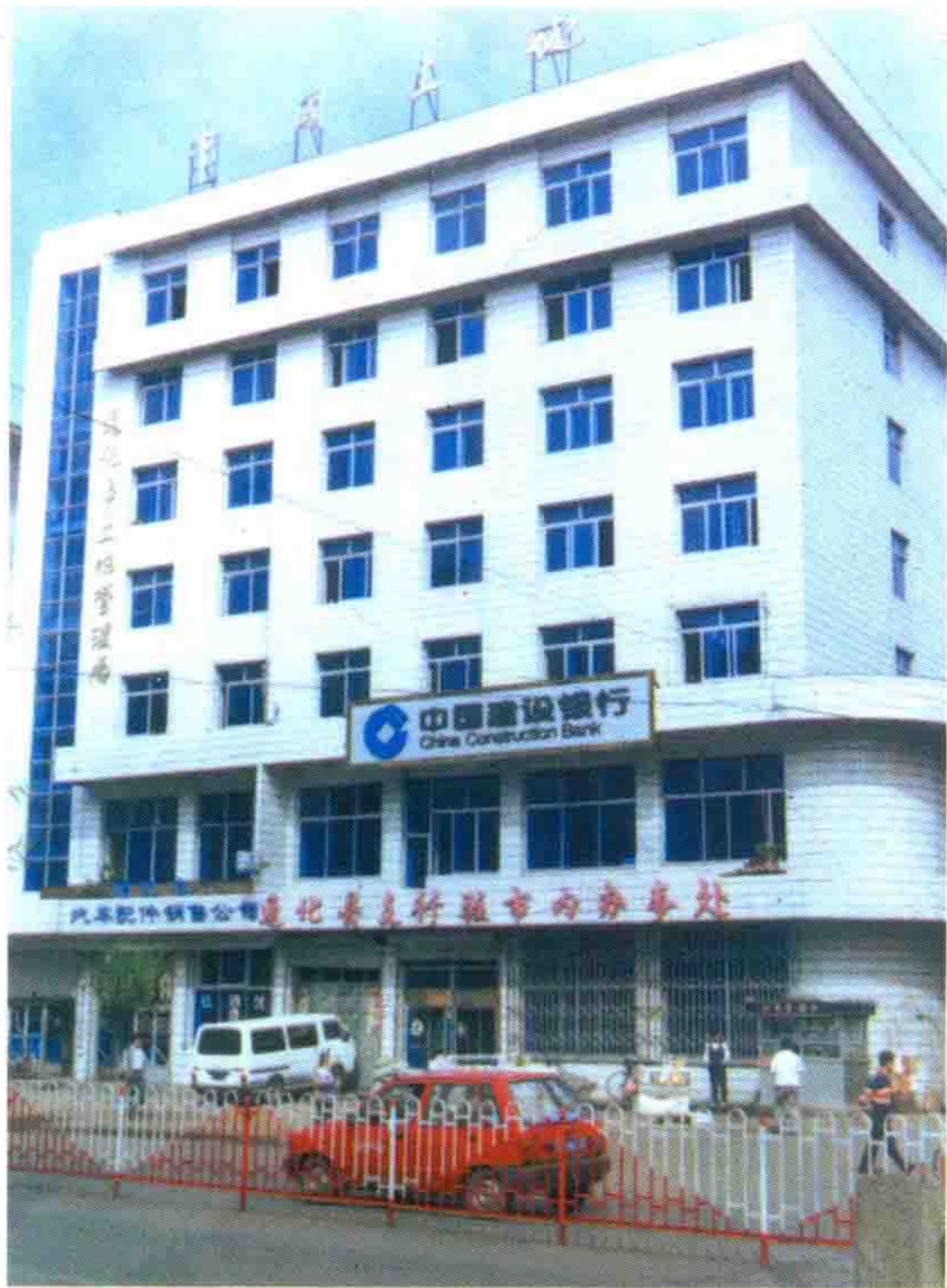
通化市土地管理局办公楼
