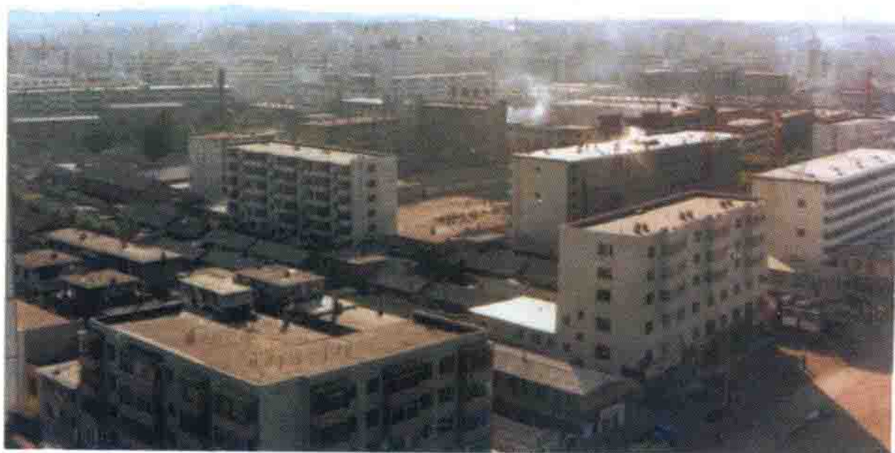
住宅小区改造——梅河口城区局部
