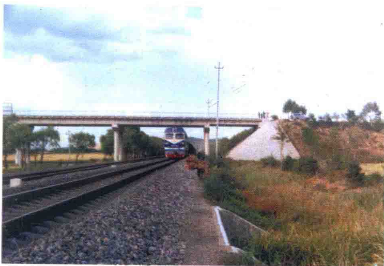
交通设施——梅河口市环路北段立交桥
