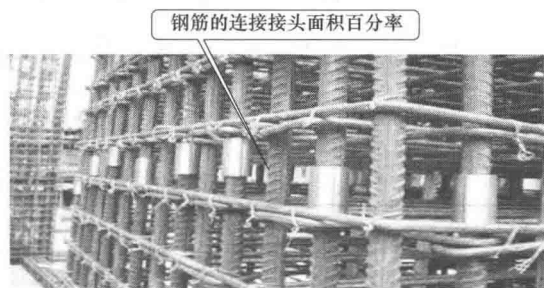
图 1-9 钢筋接头率
