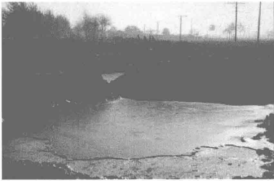
图 1.3 管线腐蚀泄漏的原油污染水塘
