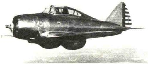
P-35战斗机还有一个巨大的进步，就是装备了可收放起落架。在飞行的时候，它的起落架会收放到机翼的起落架舱里，大大降低了机身下的空气阻力。
