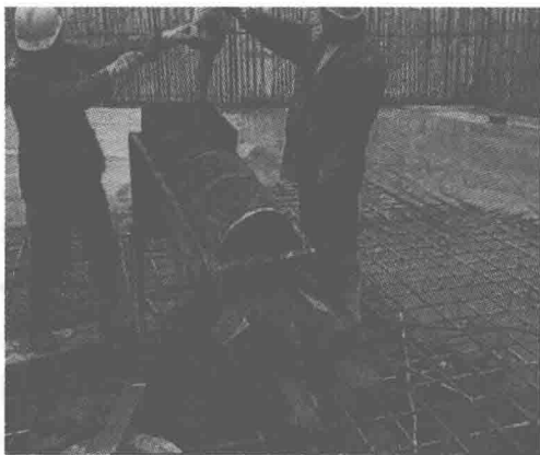
图 1-8 混凝土骨料粒径选择浇筑作业
