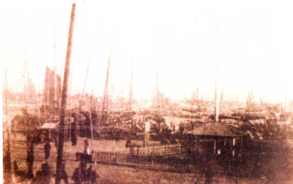
1861 年, 营口对外开埠。图为营口港一角
