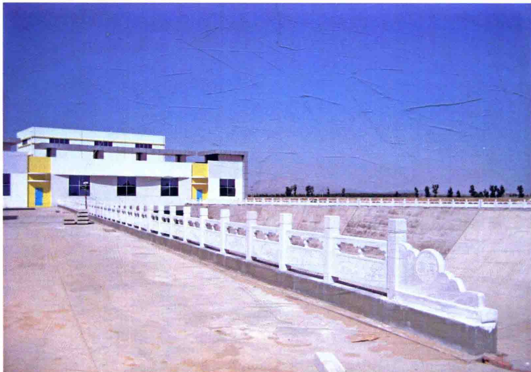
渠道倒虹吸进口闸
