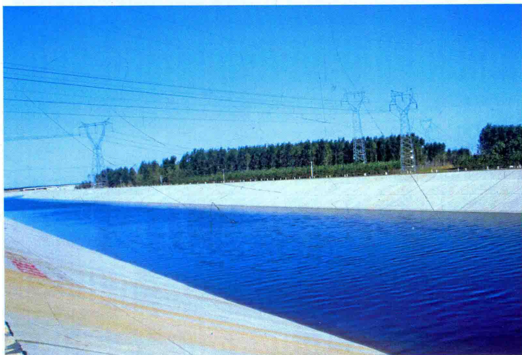
通水后的南水北调干渠
