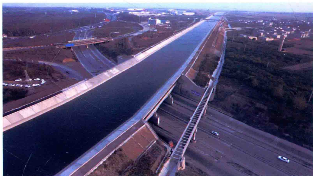
分离式扶壁梯形渡槽
