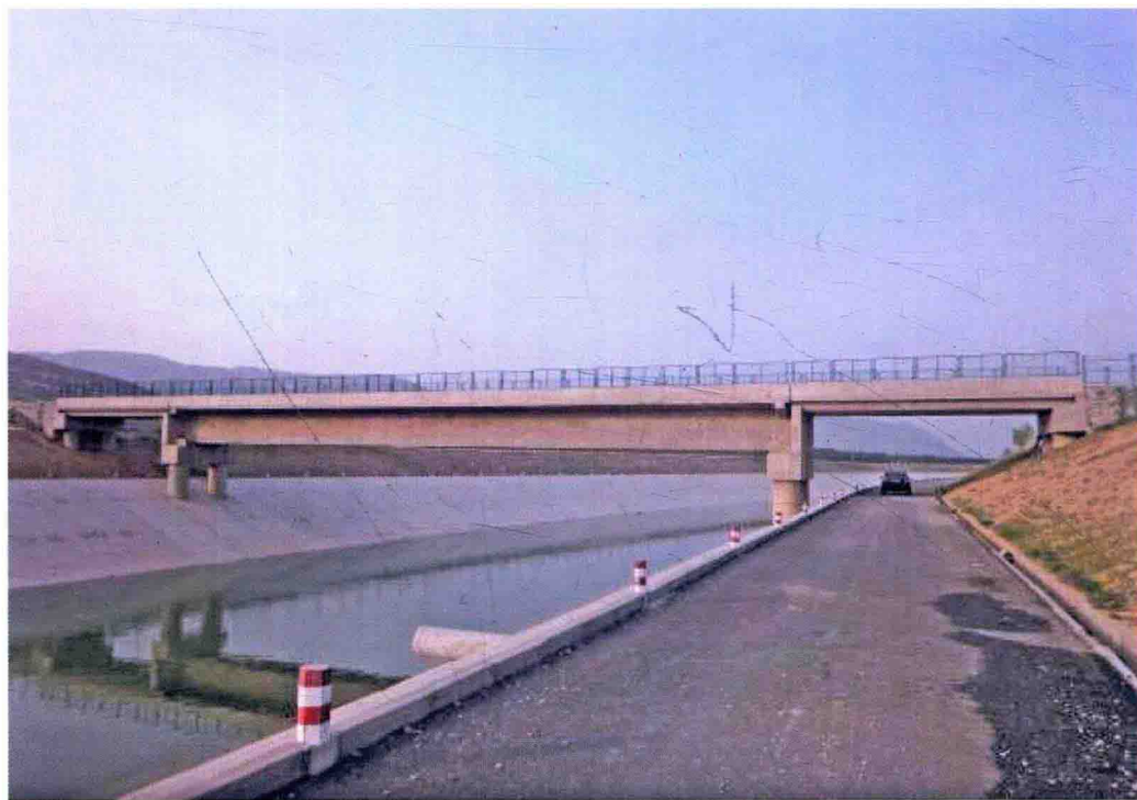
干渠跨渠桥梁及巡渠道路
