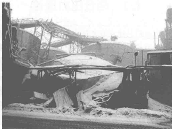
图 1-2 新疆天业电厂承建筒仓倒塌事故
