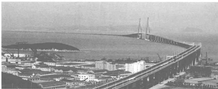
图 1-3 金塘大桥实景
