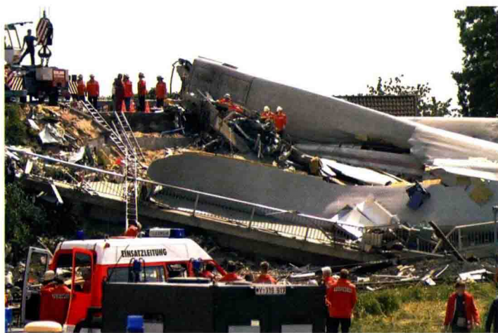
图 1-1 德国 ICE1 高铁事故现场
