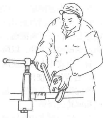
图 2-8 用管钳进行管子 螺纹连接操作
