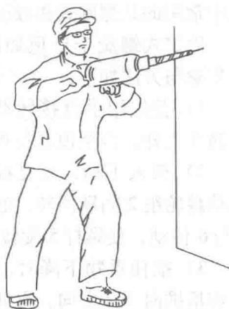
图2-12 用电锤在墙上 錾打过墙眼
