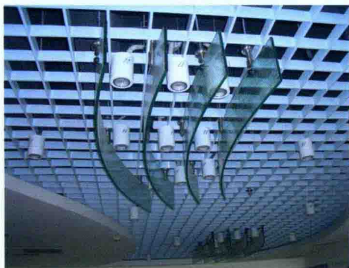
图37 高位筒灯与吊顶造型
