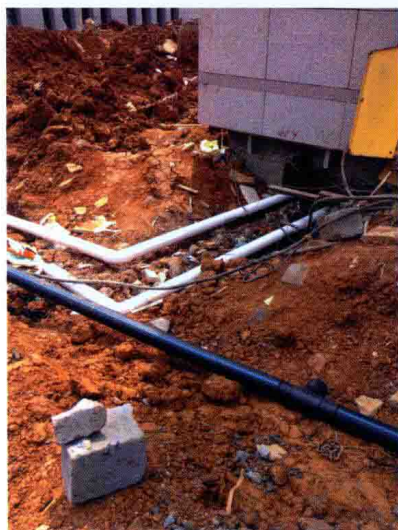
图23 大量采用90度弯头过渡的错误做法
