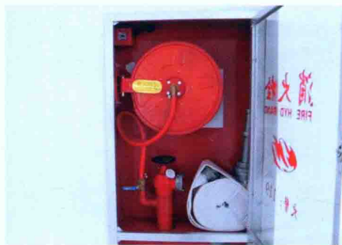
图40 室内消火栓箱安装
