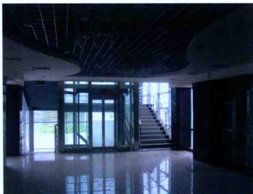
图33 装修工程吊顶及灯具安装
