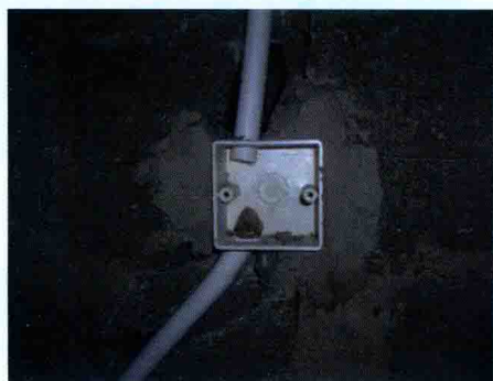
图9 暗配电线管进盒未加锁扣
