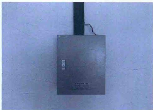
图41 动力配电箱及桥架安装
