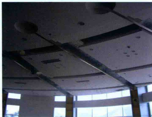
图36 大型会议室吊顶及灯具安装
