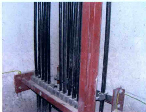
图44 预分支电缆在电气竖井内安装
