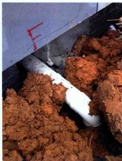
图24 明显采用90度弯头过渡的错误做法
