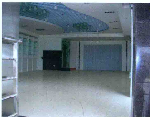
图31 装修工程吊顶及灯具安装
