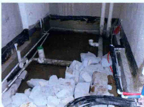
图26 卫生间用大块建筑废料回填
