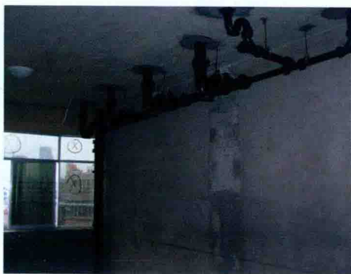
图32 柔性铸铁排水管道安装
