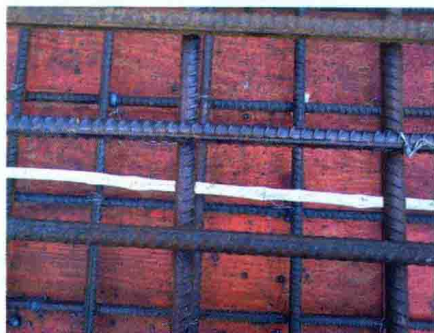
图13 已被压扁的电线管
