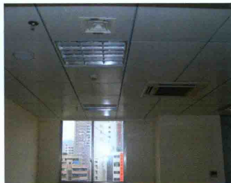
图47 吊顶上方风口、格栅灯盘安装
