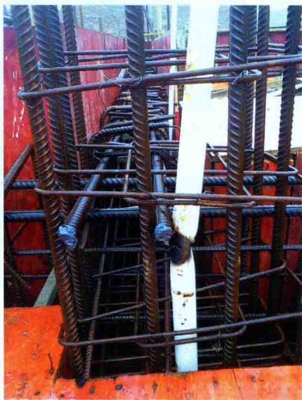
图10 成品保护意识差，烧坏预埋的电线管
