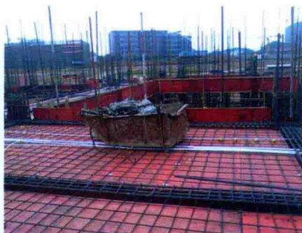
图12 不按规定装卸货物，将重物压在预埋电线管上
