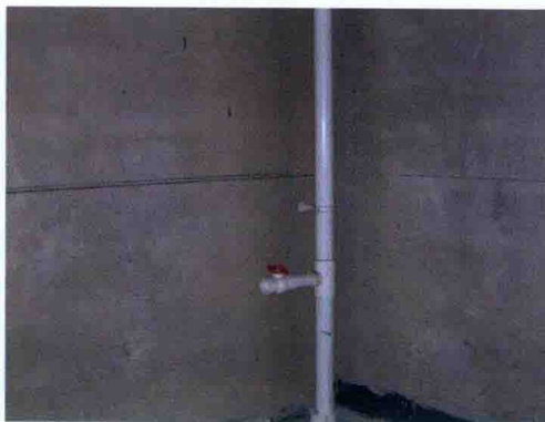
图30 PVC-U给水管道安装
