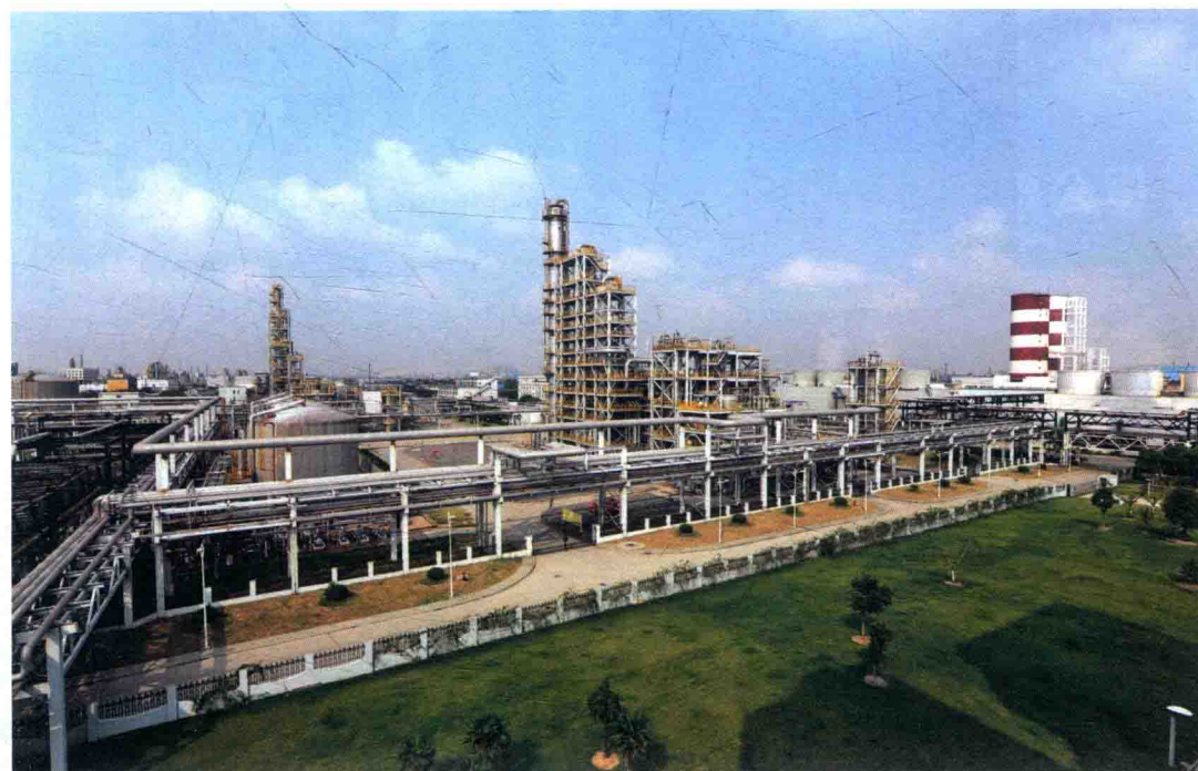
● 上海华谊（集团）公司无为基地——安徽华谊公司生产装置一景
