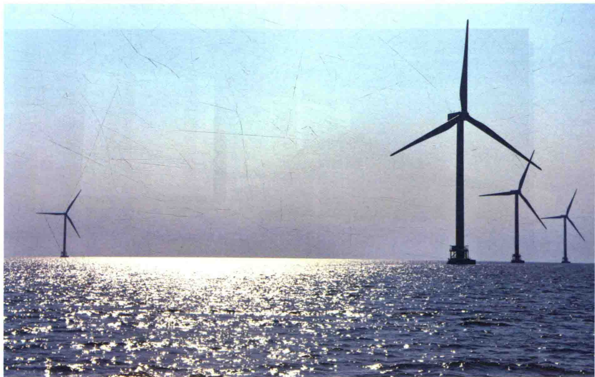
● 上海电气（集团）总公司所属风电项目东海大桥二期
