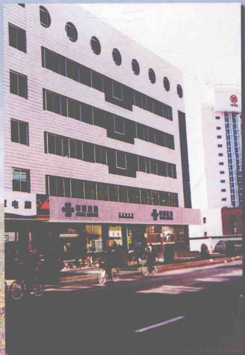
新建的联通分公司大楼
