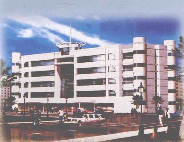
新建的吴忠移动公司大楼
