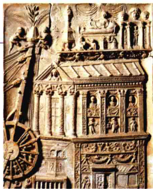
使用起重机修建房屋
