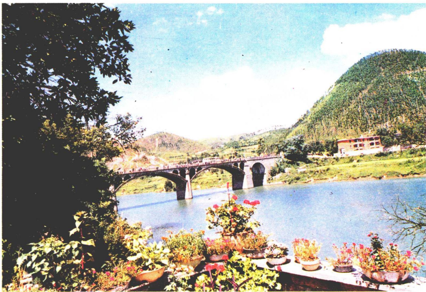
麻江县下司大桥全景
