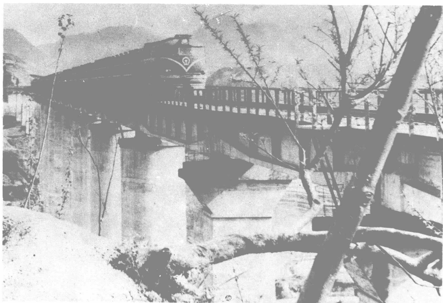
麻喇铁路大桥
