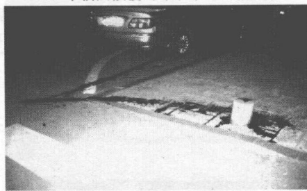
(j) 车辆因托底而导致机油泄漏污染路面
