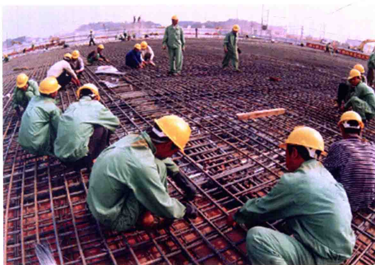
广州大学城建设过程中
