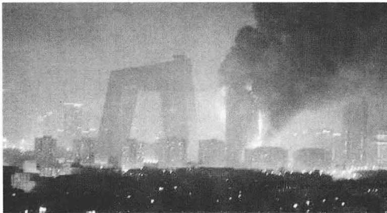
图1-2 中央电视台新址园区火灾事故
