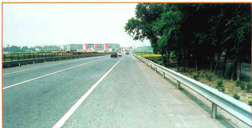
▲西兴镇境内钱江三桥接线公路
