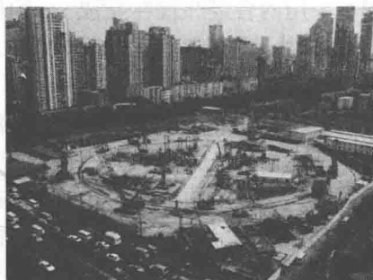
图 1-7 施工时场地全貌
