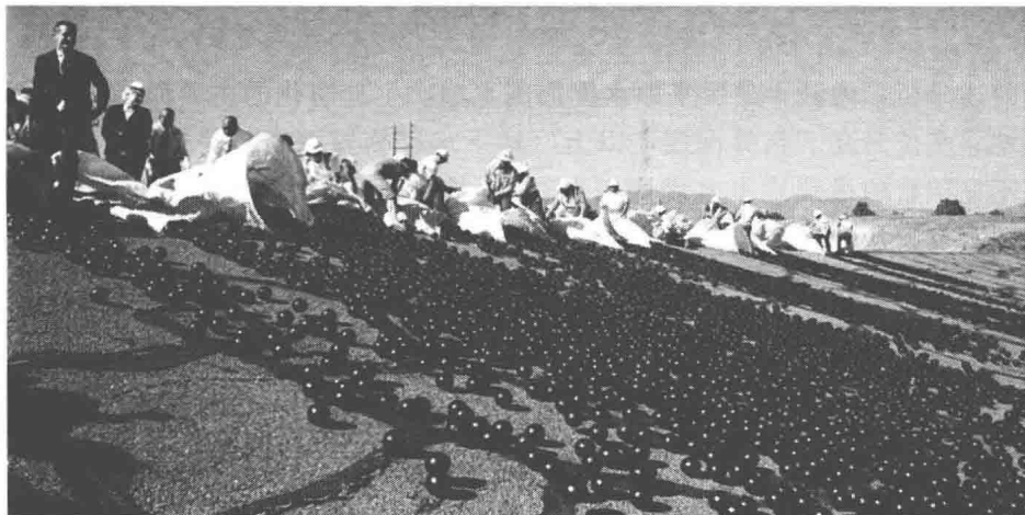
图 1.2 施工人员在水库大坝上游坡将塑料球投放滚入水库
