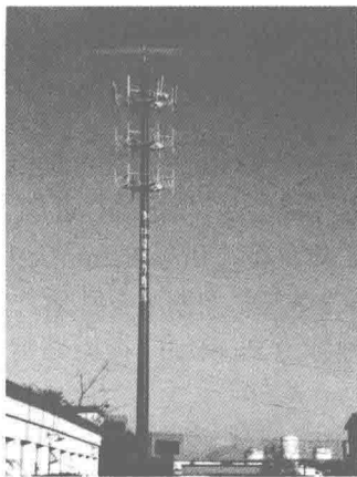
图 1-8 MacroCell 基站示意图
