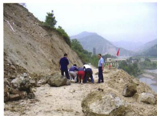
6月25日区司法局赴平武慰问途中不顾危险排除道路障碍
