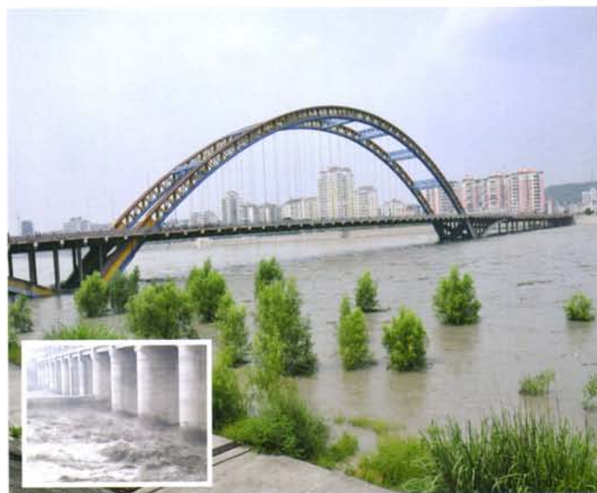
6月10日15时15分唐家山堰塞湖泄流洪峰顺利通过绵阳城区，17时通过三江闸坝，最高流量7100立方米每秒
