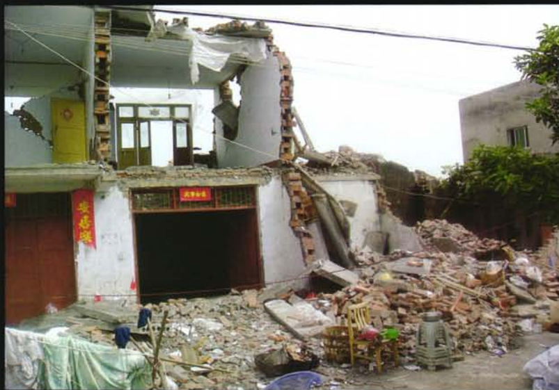
龙门镇受损倒塌农房
