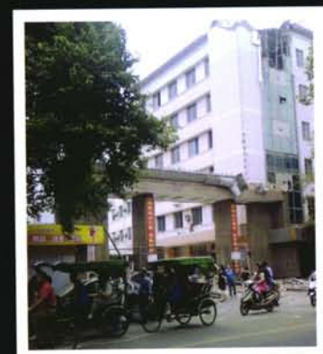
区委机关受损的1号综合办公楼
