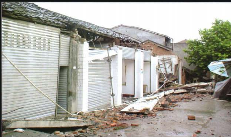
金峰镇受损房屋
