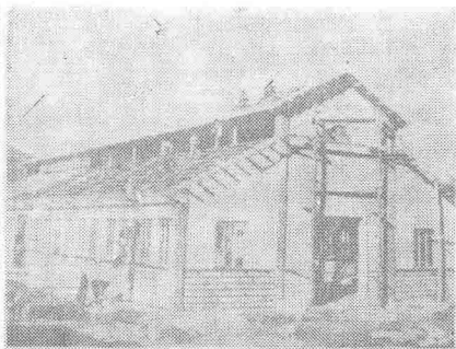
1956年1月兴建中的公私合营厦门机器厂的厂房已基本完成。
