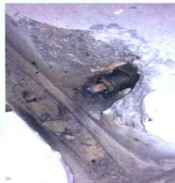
(h) 张拉完成、烧断剩余钢绞线
