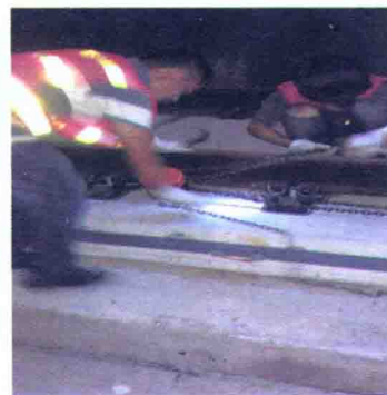
(d) 使用葫芦装置拉出钢绞线
