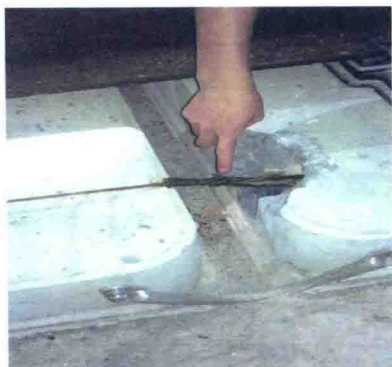
(e) 钢绞线拉出后切断中心丝
