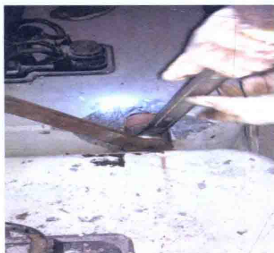
(g) 采用两端张拉钢绞线
