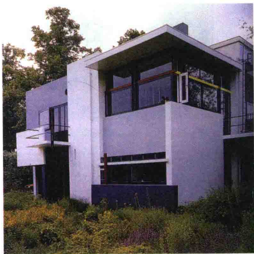
图1-3 施罗德住宅 里特维德
