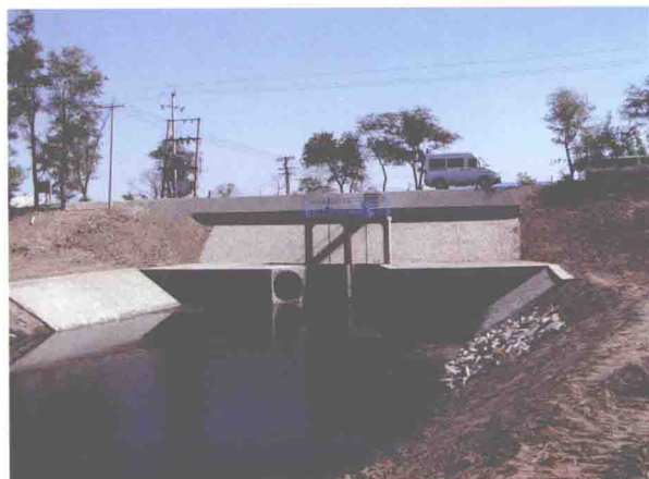
▲东丽区实施金钟河右堤欢坨二线泵站排灌闸 维修加固 (摄于2005年5月)
