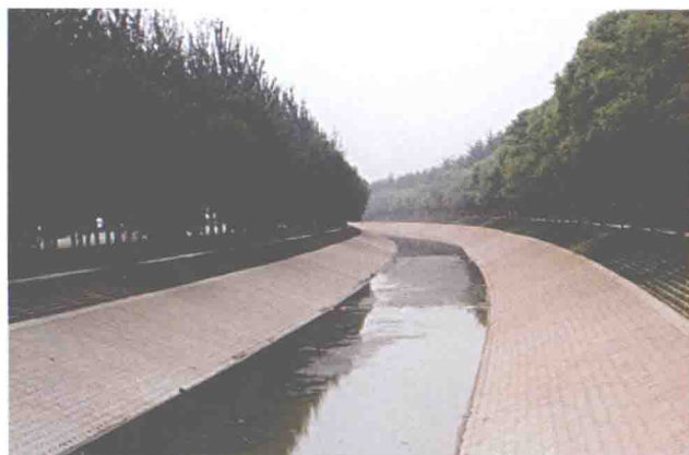
▲治理后的外环河顾庄段（摄于2010年5月）
