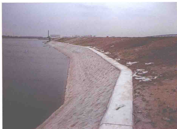
▲东丽区实施海河左堤苏庄段浆砌石护坡 (摄于2010年5月)
