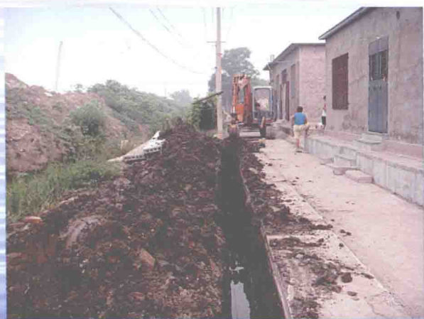
▲东丽区新立街新兴村管网入户和饮水安全施工现场（摄于2010年7月31日）
