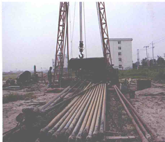
▲东丽区教绿科技园区凿井施工现场（摄于2010年4月）
