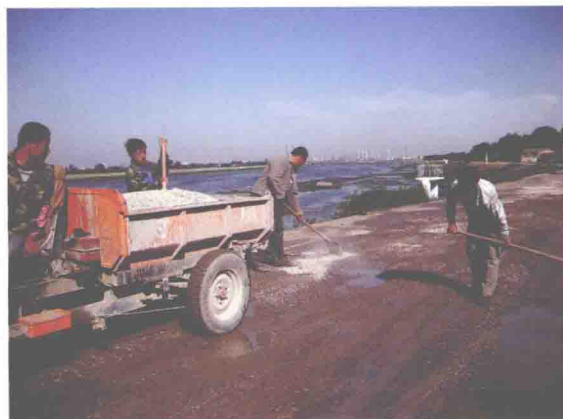
▲东丽区进行海河左堤泥窝段泥石路面养护 维修 (摄于2009年4月)
