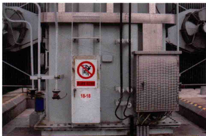
图 2-10 变压器本体一侧可见光图
