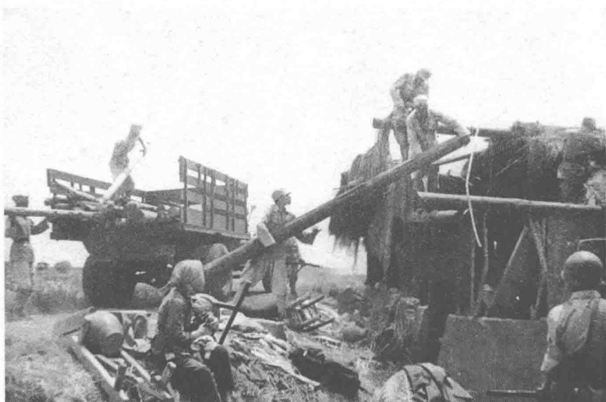
19 江南岸，敌军为了修筑防御工事，将附近民房全部拆除，将房屋上的木料运去修筑工事。
