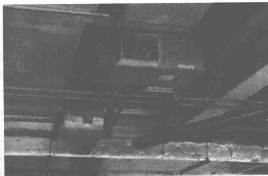
图 1-2-3 风机盘管完工后用塑料布包裹
