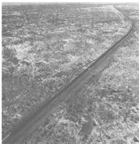
图 0-3-4 澳大利亚纽曼山—海德兰重载铁路列车
