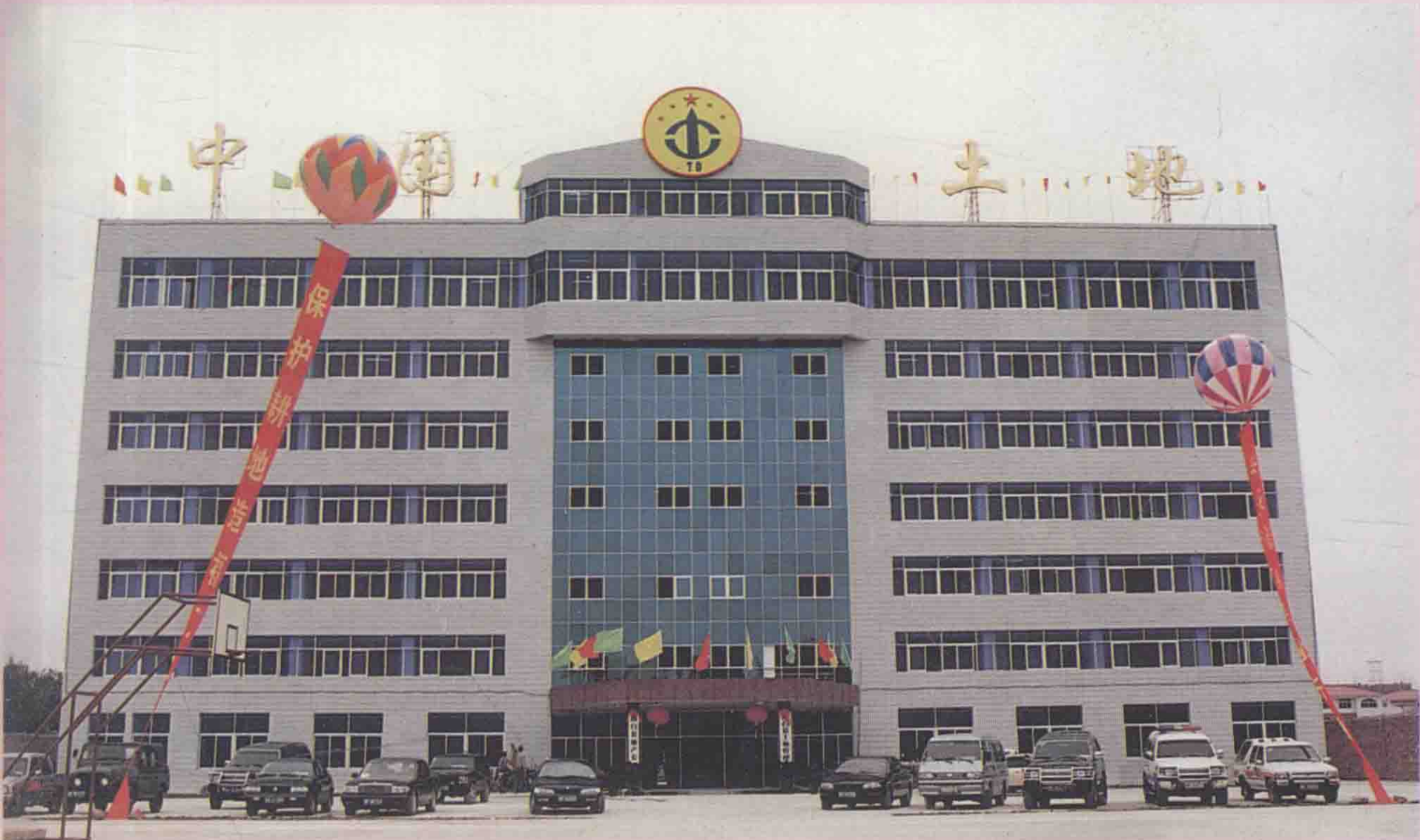
博白县土地管理局办公大楼
