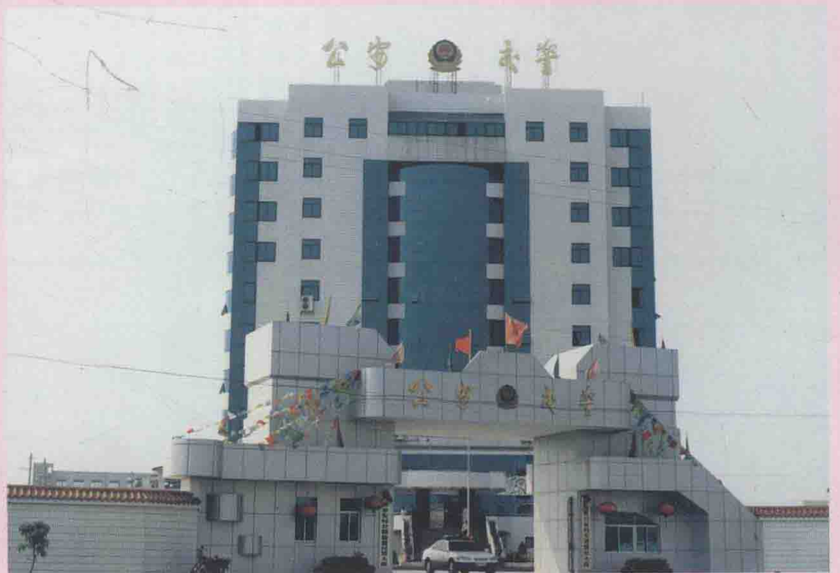
县交警大队办公大楼
