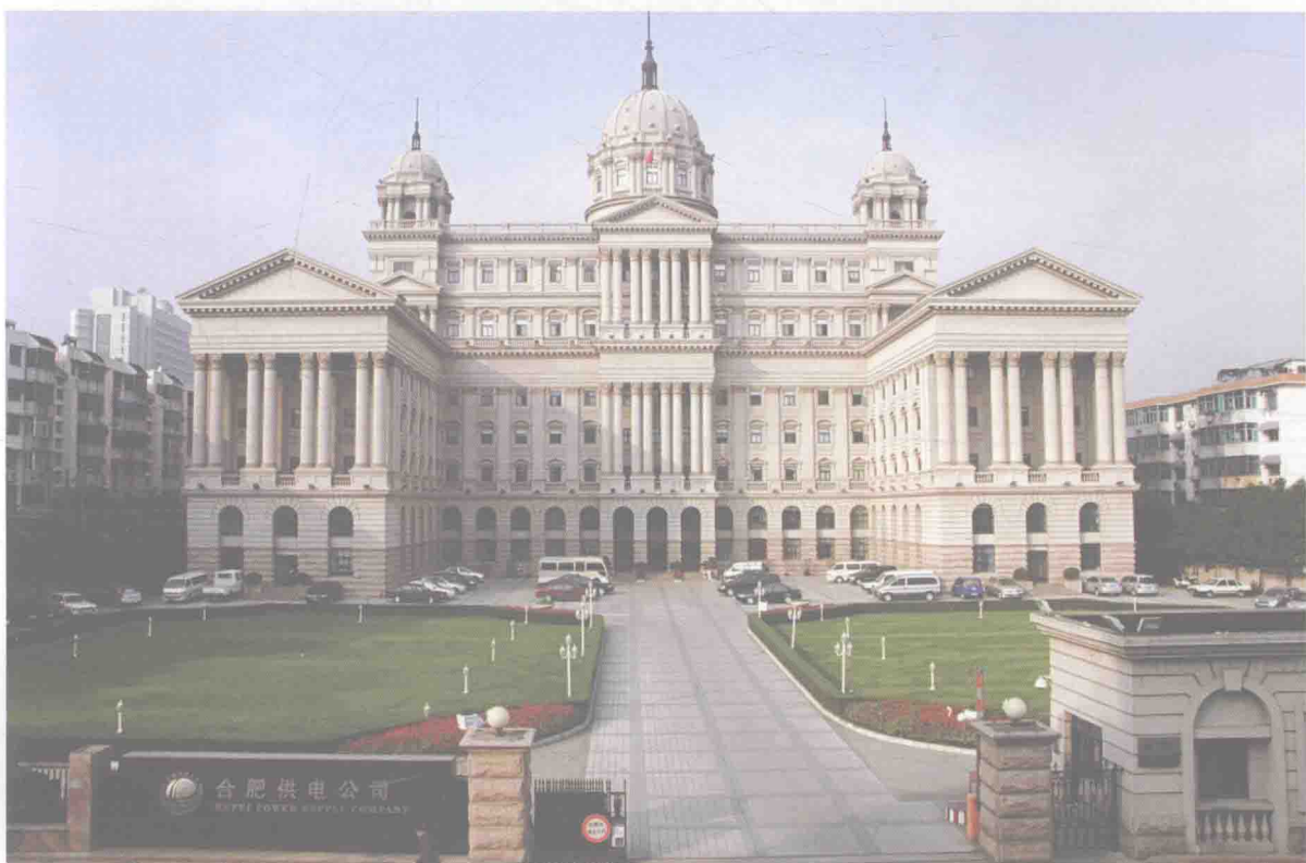
合肥供电公司电网调度大楼
