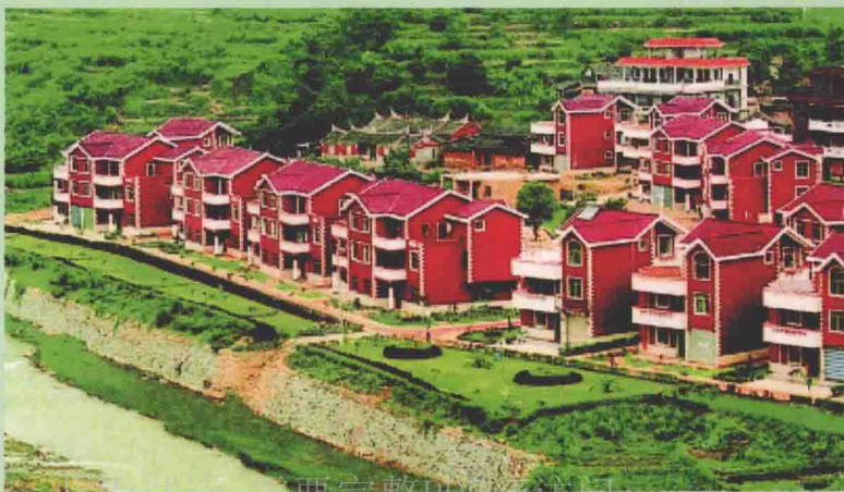
南安市英都镇溪益住宅小区
