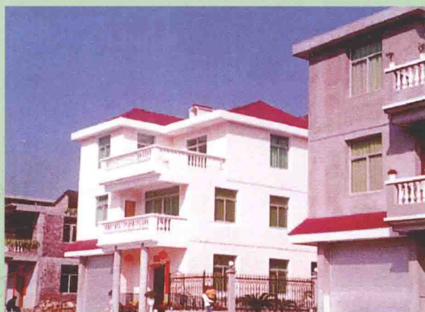
龙岩市新罗区龙门镇湖坑村住宅小区
