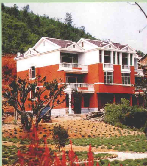
顺昌县埔上镇口前住宅小区 ◀
