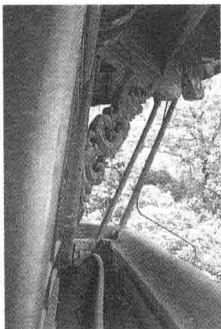
图 1.6 构件变形
