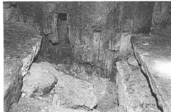
图 1.4 木柱腐朽
