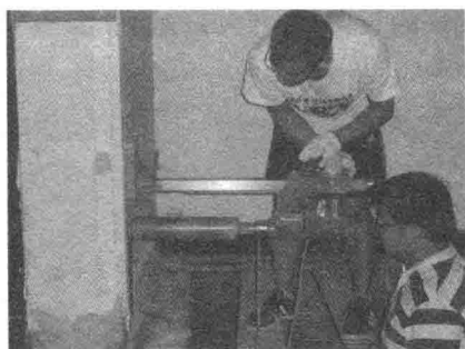
图 2.8 混凝土取芯机
