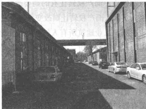
图 1.5 改建后的厂房新设的管路
