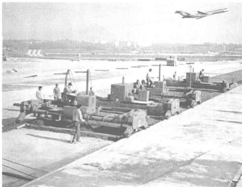
图 1-5 固定模板法水泥混凝土面层施工
