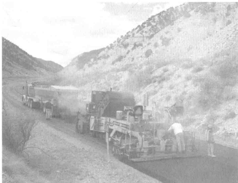
图 1-3 沥青路面施工图
