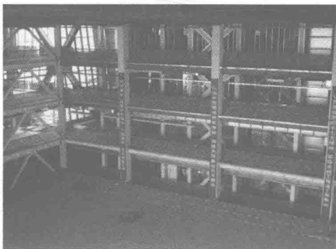
图 3-4 楼层临边安全防护（二）
