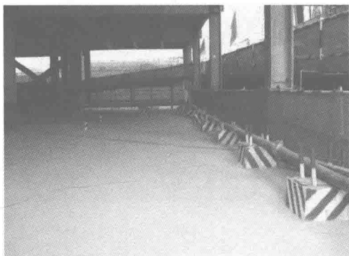
图 3-19 混凝土泵管固定点
