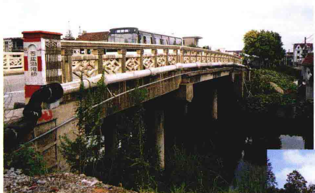
石皮泖港上的公路桥。
